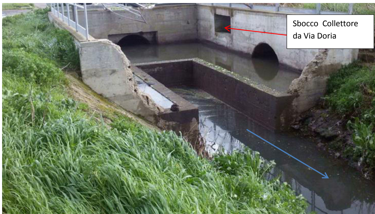
Riproduzione fotografica del pozzettone ripartitore
